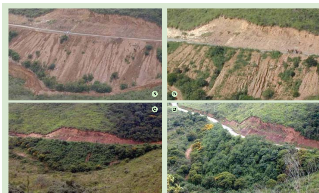
Figura 2.28: Processo de desenvolvimento da vegetação nativa em talude recuperado pela transferência de banco de sementes alóctone - talude antes da transferência (A), vista do talude depois de 3 meses (B), 9 meses (C) e 14 meses (D).
